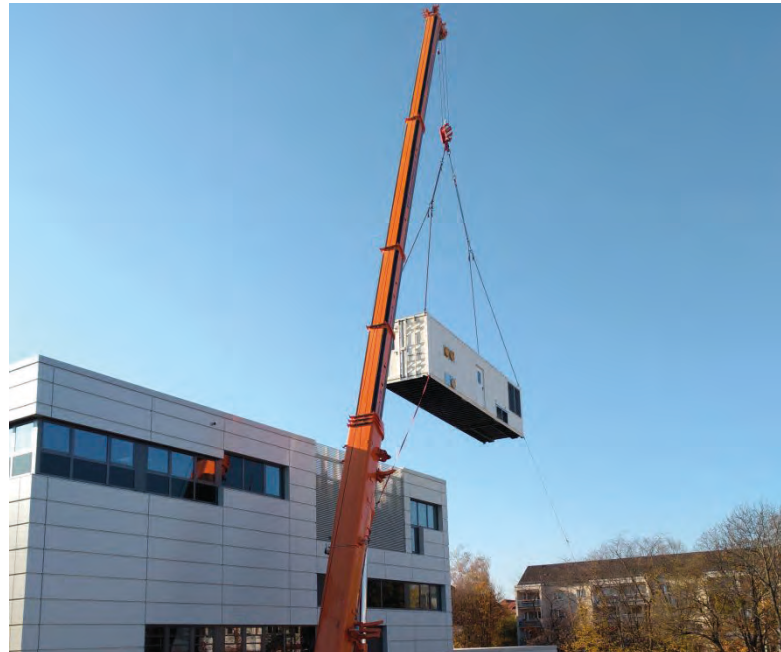
Anlieferung der Testanlage TABEA im Forschungskomplex für »Ressourcen-schonende Energie-Technologien« (RESET) des Fraunhofer-Institutszentrums Dresden im November 2022.
